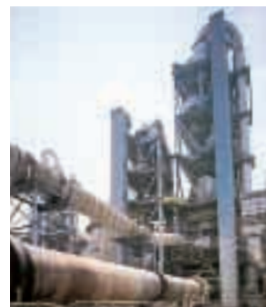
セメント工場の焼成設備
