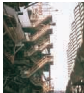
高炉原料化設備(NKK)
