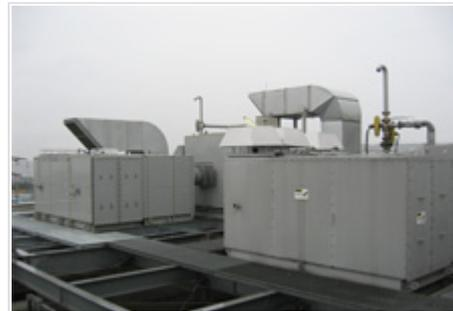
触媒酸化処理装置
