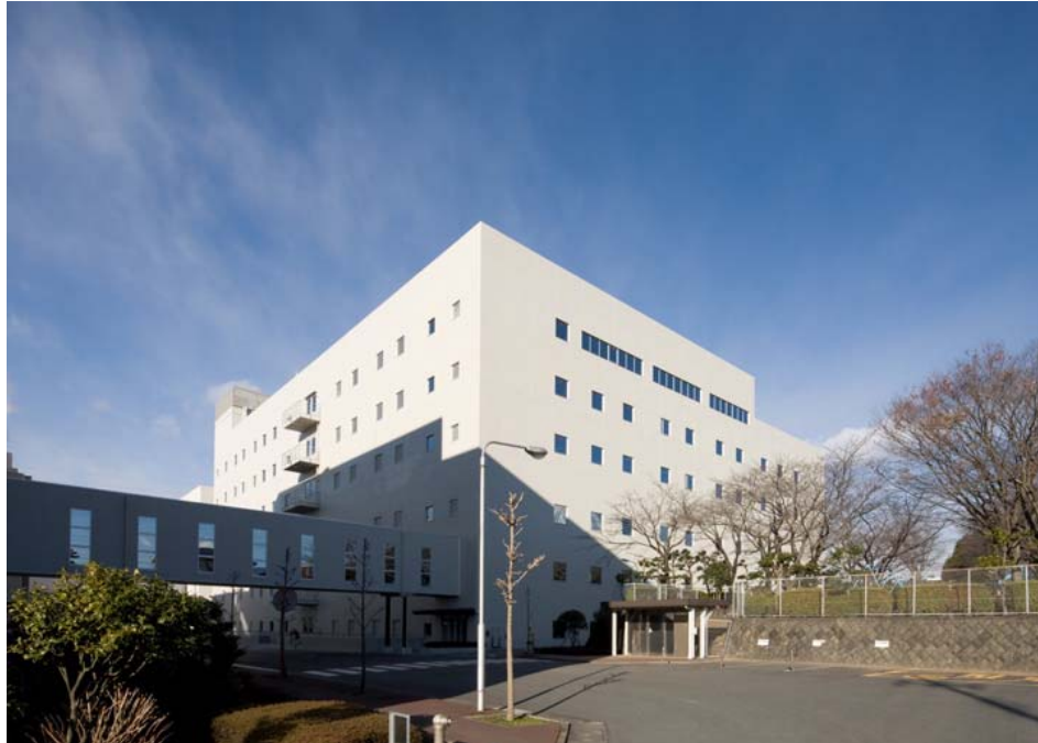
愛鷹工場新棟
