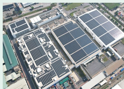
2022年度に設置した太陽光発電パネル
