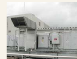
富士宮工場：触媒酸化処理装置
