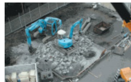
焼却炉撤去風景(基礎撤去)
