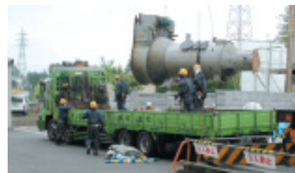
焼却炉撤去風景(排ガス処理装置撤去)
